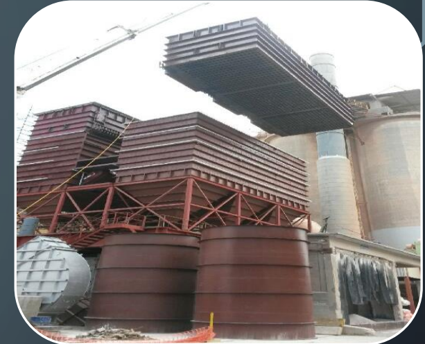
Grúas y equipos de elevación
